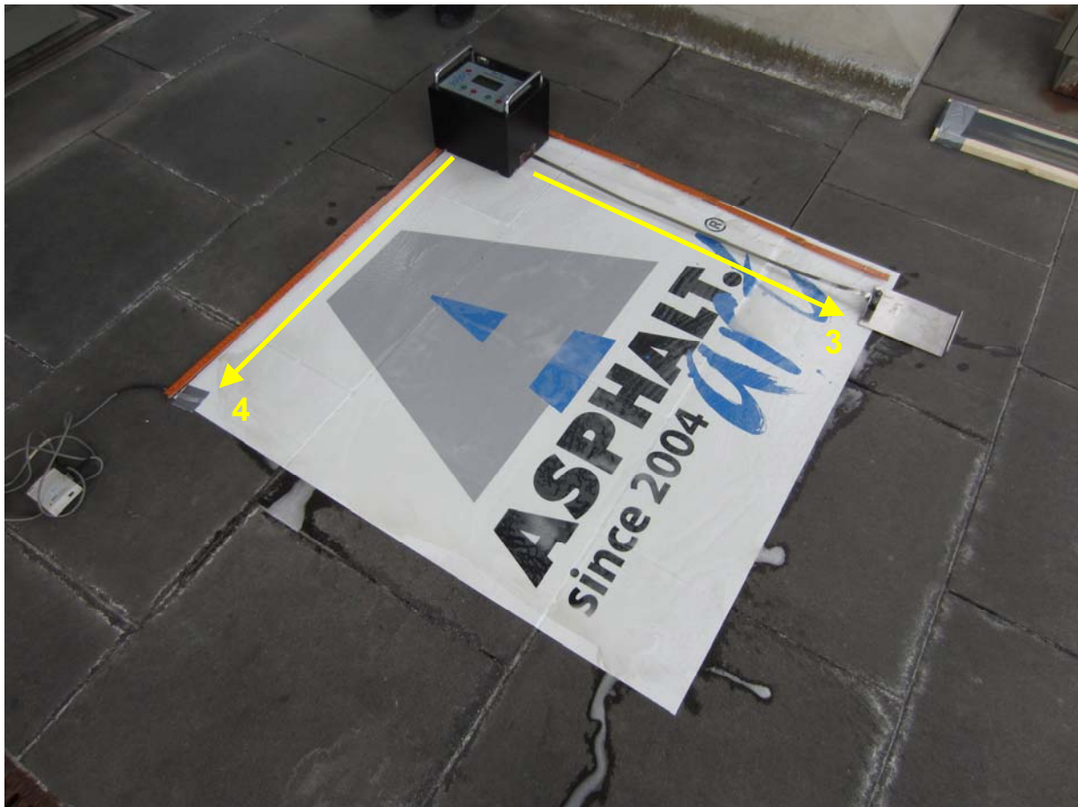
Bild 02.: Hauptbahnhof Wien, Bahnsteig 7E; selbstklebenden Fußbodenfolie Messung „nass“: Richtungen der Messreihen 3 und 4.
